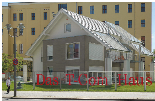
Abbildung 10.1: Das Telekom-Haus in Berlin (2005-2006) war ein Paradebeispiel für Hausautomatisierung (Quelle: http://commons.wikimedia.org/wiki/File:T-Corn-Haus_Berlin_%282005%29.jpg ).
